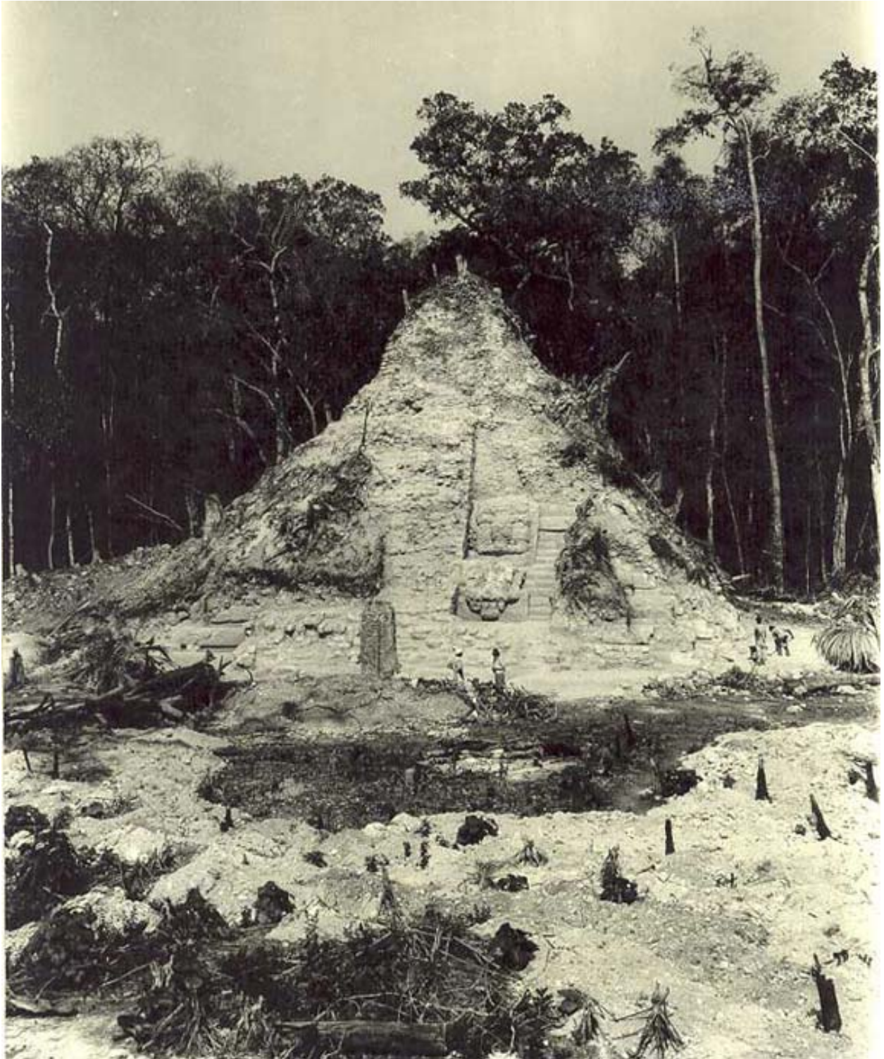
Figura 24. Vista de las excavaciones de la Estructura E-VII de Uaxactún.
