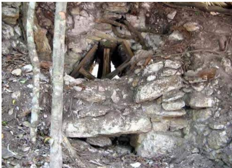
Figura 21b. Pasillo abovedado B-14A.
