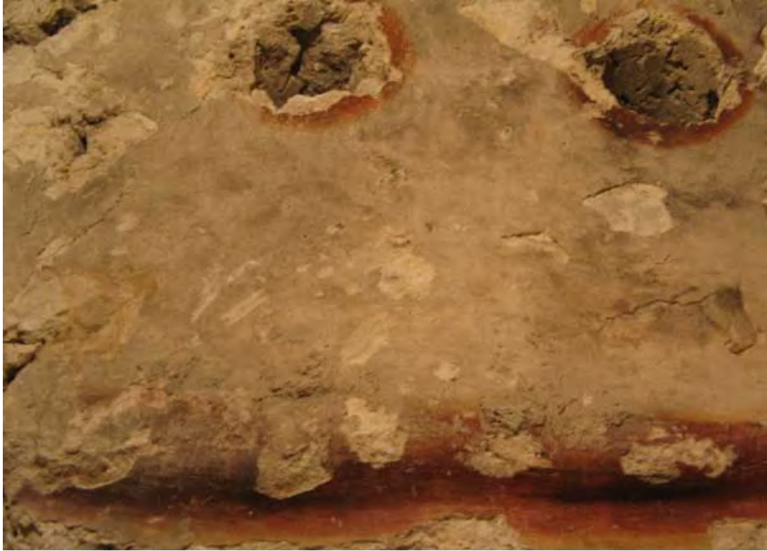
Figura 32b. Palacio B-15, bóveda, soffito y agujeros de vigas.
