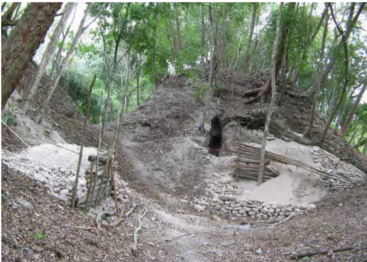
Figura 48. Edificio B-16, saqueo.
