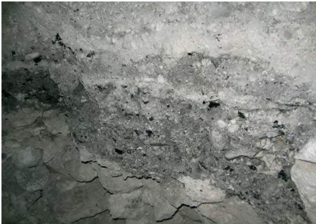
Figura 43b. Capa de carbón en bóveda de recinto 4.
