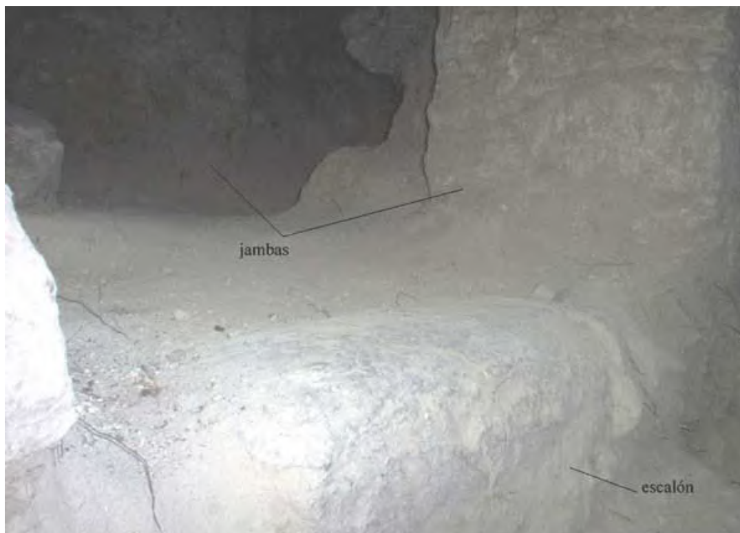
Figura 22b. Pasillo abovedado B-14B.
