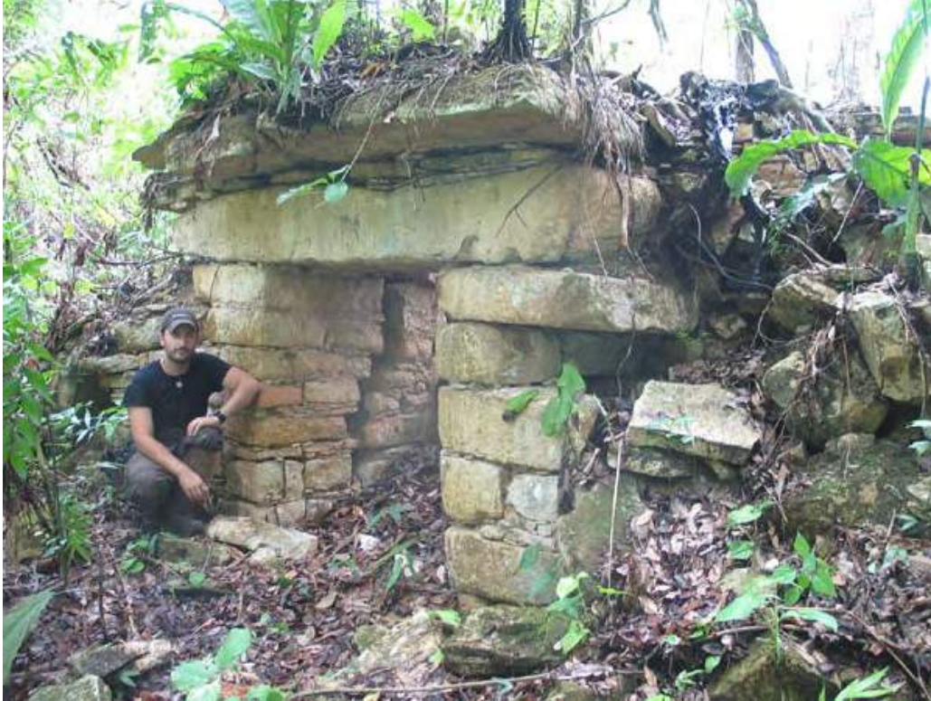
Figura 12. Puerta sureste del Palacio Las Puertas, Oso Negro. Nótese que la puerta está llena de escombros, lo que da la apariencia de que no fue construida a toda la altura.
