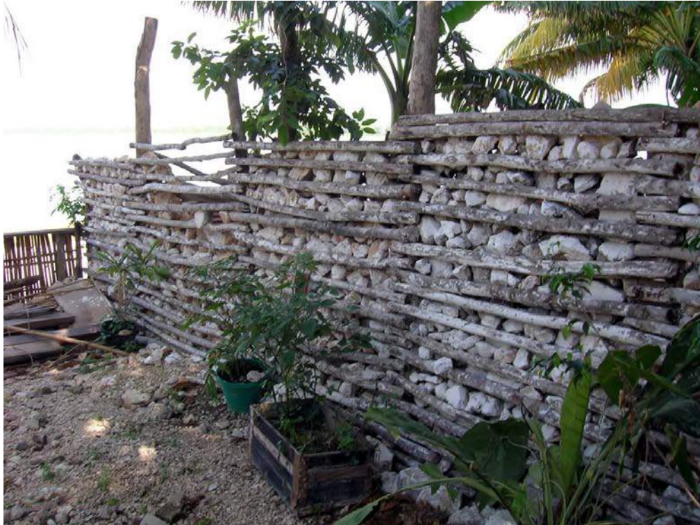
Foto 27. Técnica de pretil, aun utilizada para construir paredes sobre plataformas de piedra.
