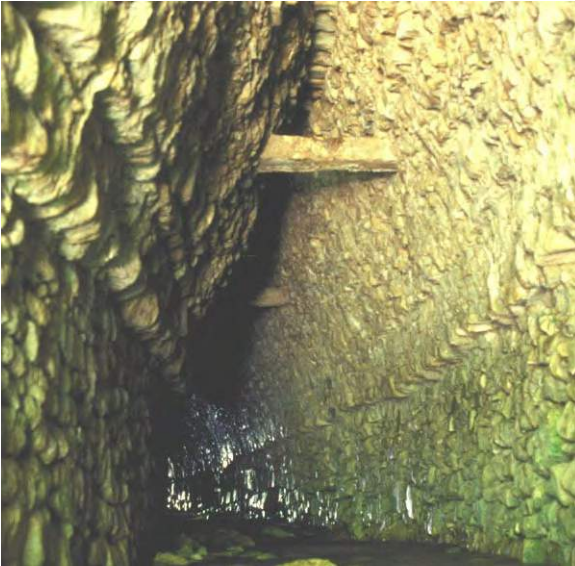
Figura 3. Acueducto del palacio subterráneo de Palenque.
