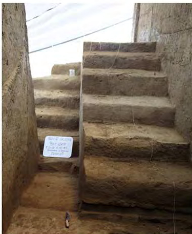
Figura 10. Trinchera al sur de la Plataforma Norte: escalinata principal de la primer y segunda etapa constructiva, que se levanta de un paleo-suelo (arriba: tramo superior, abajo: tramo inferior).
