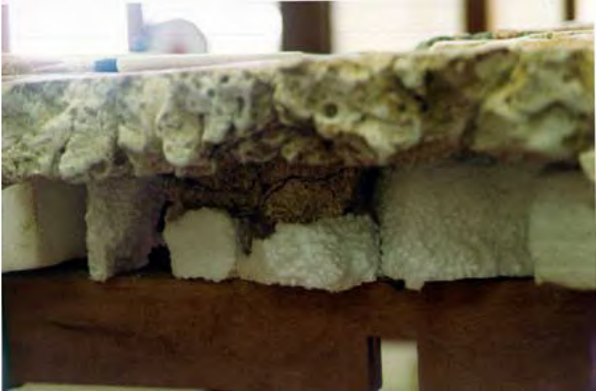
Foto 54. Soportes provisionales de placas de poliestireno
