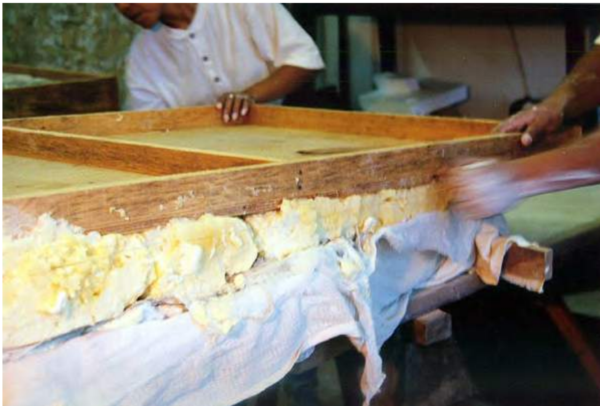
Foto 37. Retiro de las capas aislantes del desprendimiento
