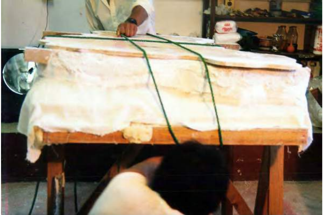
Foto 35. Volteado del fragmento desprendido del muro
