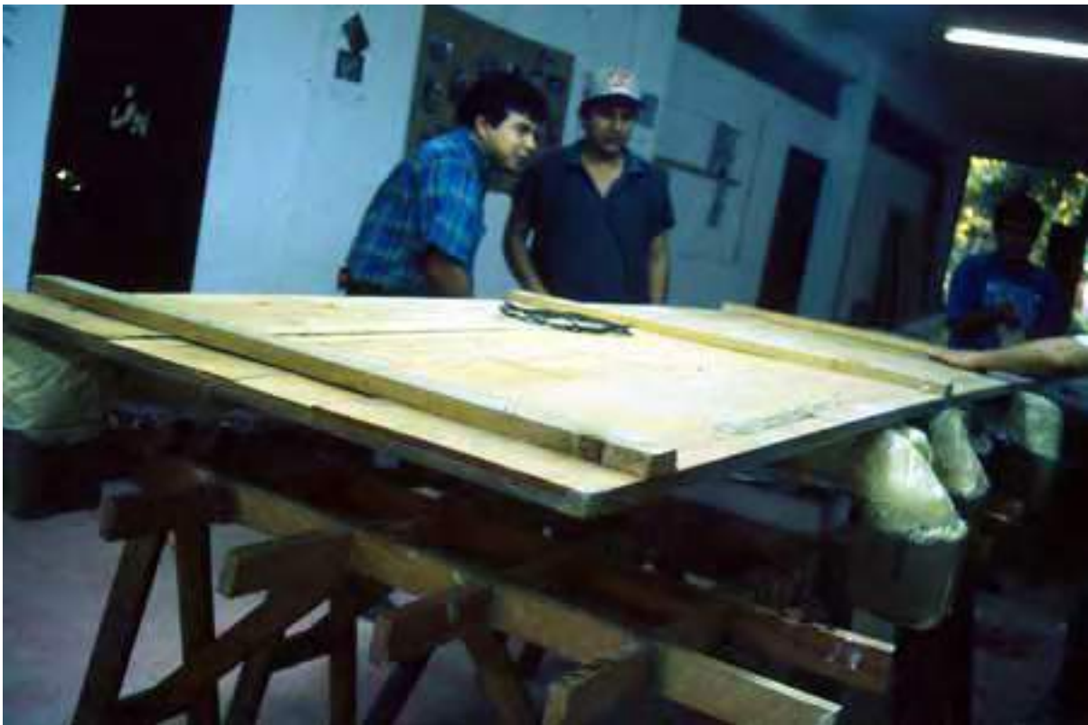
Foto 67. Colocación de la tabla para voltear el panel de estuco
