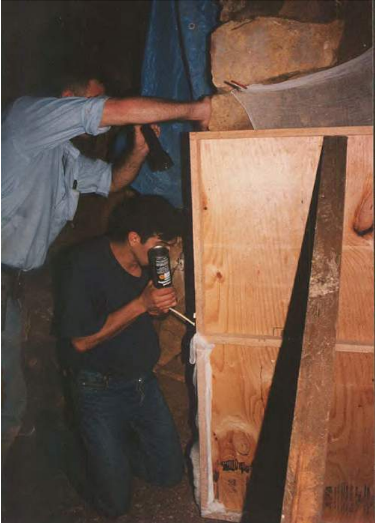
Foto 13. Inyección de espuma de poliuretano
