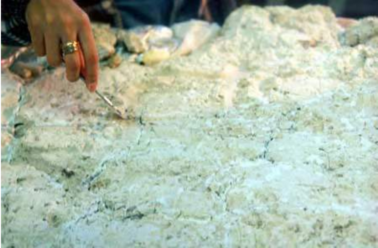
Foto 23. Consolidación de grietas y fisuras por el reverso del desprendimiento
