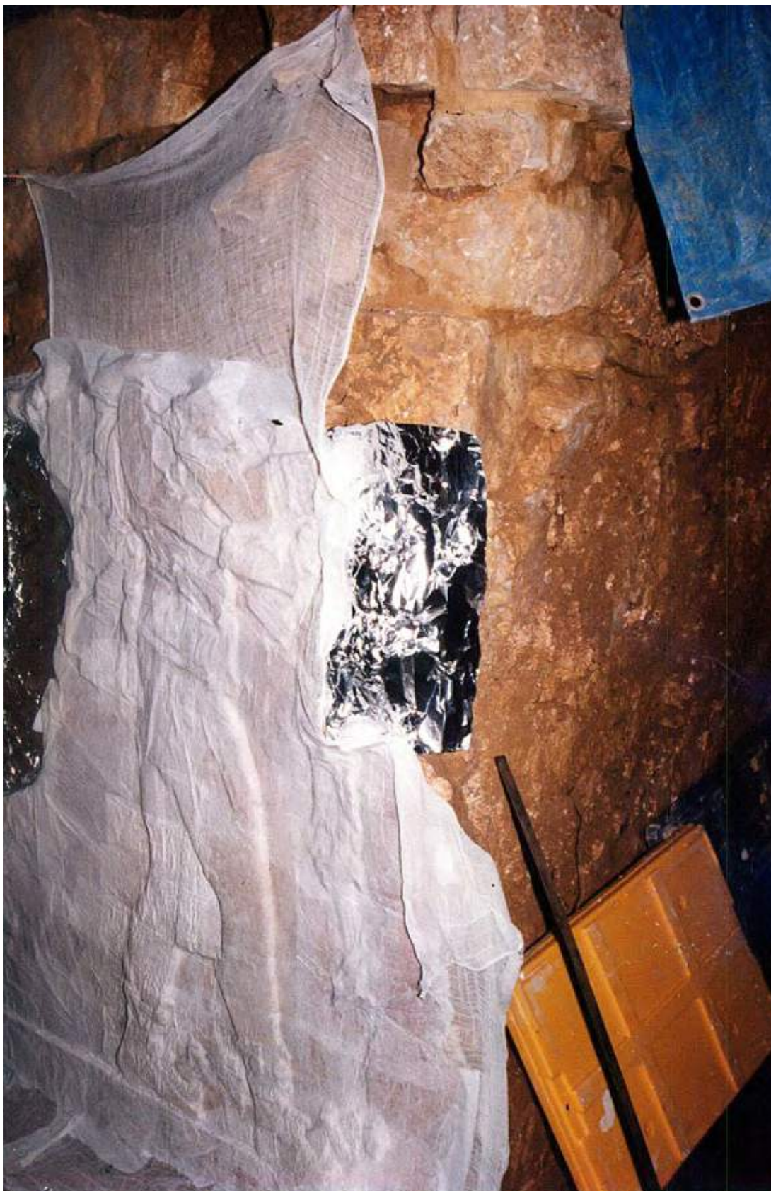
Foto 11. Velado general de protección
