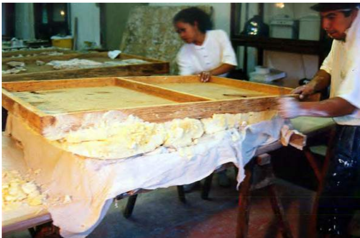
Foto 38. Retiro de la tabla de soporte del área desprendida del muro
