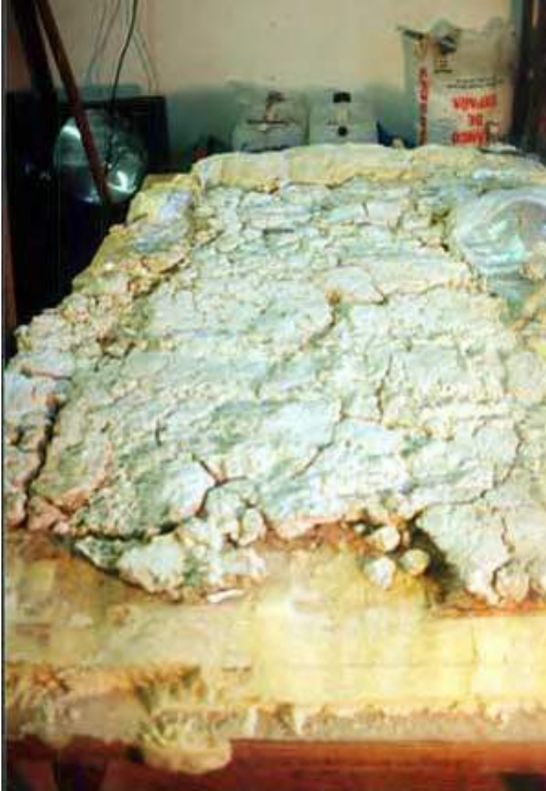
Foto 20. Limpieza superficial por el reverso del fragmento desprendido
