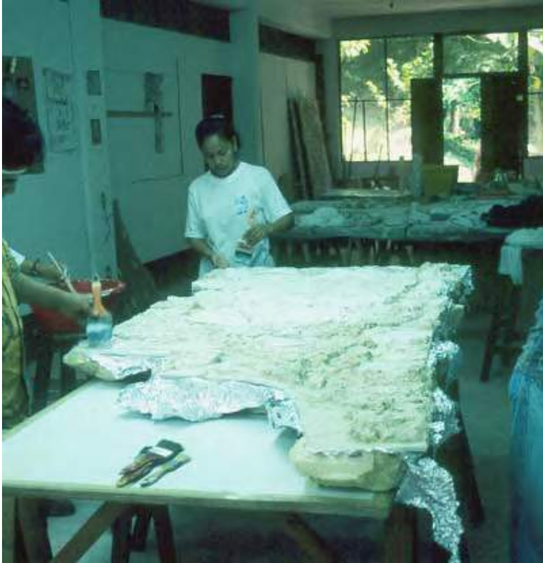
Foto 70. Aplicación de la capa de caseinato de calcio
