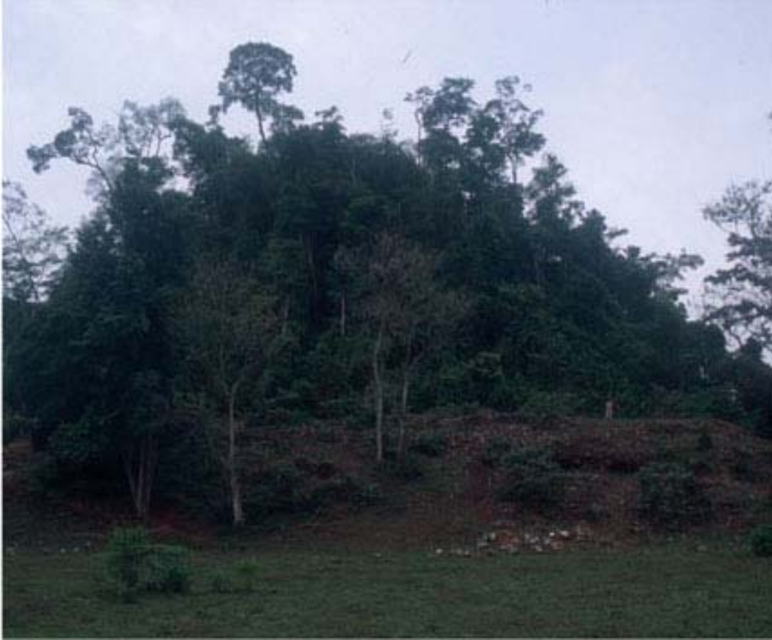
Figura 6. Estructura palaciega construída contra una colina sagrada sobre el lado este de la plaza principal, Raxruja Viejo. Para tener una idea de la escala, nótese una persona de pie sobre la estructura.
